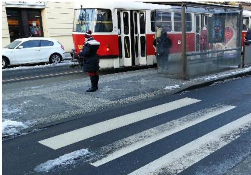
Obrázek 50: Snížený obrubník u přístupu na nástupní ostrůvek [foto Krčál]
