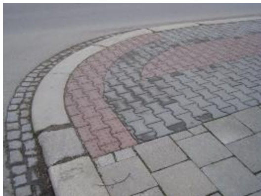
Obrázek 21: Příklad povrchu z betonové dlažby [6]
