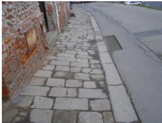
Obrázek 34 – Příklad zvlněného povrchu s velkými nerovnostmi [6]
