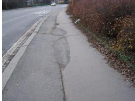
Obrázek 19: Příklad povrchu z litého asfaltu [6]
