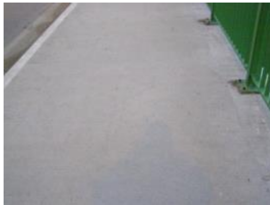
Obrázek 18: Příklad povrchu z litého betonu [6]
