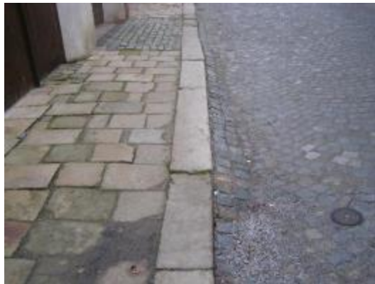
Obrázek 23: Příklad povrchu z kamenné dlažby [6]
