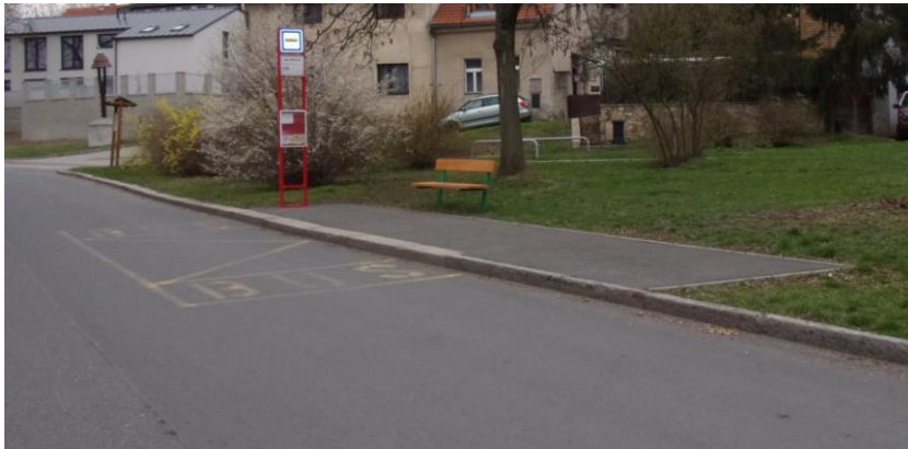
Obrázek 52: Nezajištění přístupnosti na zastávku [foto POV]
