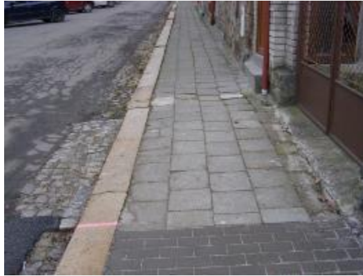
Obrázek 33 - Příklad mírně zvlněného povrchu s malými nerovnostmi [6]
