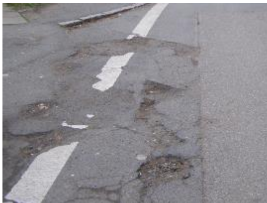
Obrázek 37 - Příklad povrchu s většími poruchami [6]
