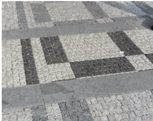
Obrázek 22 – Příklad povrchu z kamenné dlažby [foto POV]
