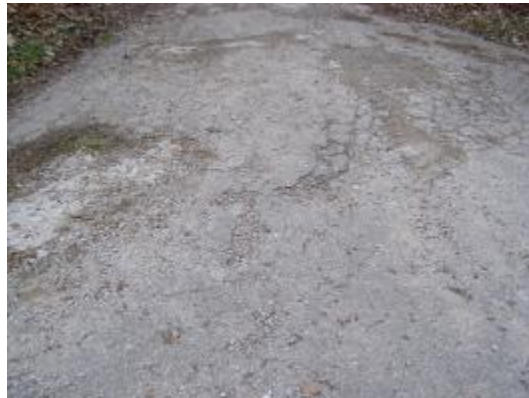
Obrázek 39 - Příklad povrchu s velkou četností poruch [6]
