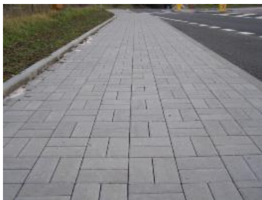
Obrázek 32 - Příklad rovného povrchu bez nerovností [6]
