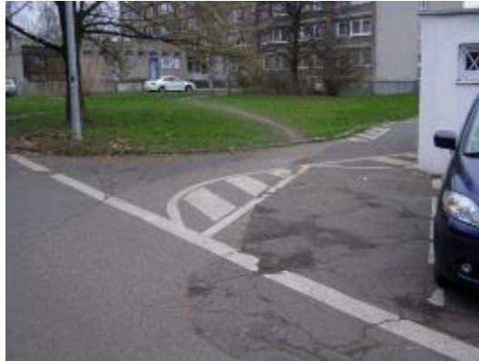
Obrázek 38 – Příklad povrchu s malou četností poruch [6]
