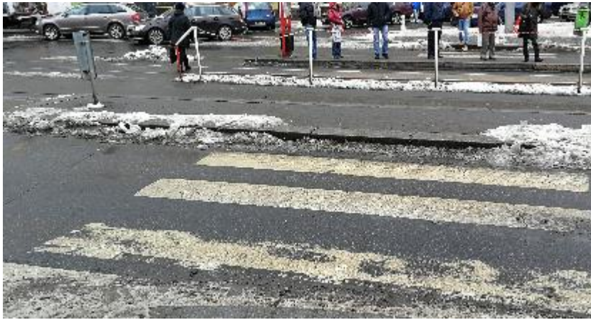
Obrázek 51: Nesnížený obrubník u přístupu na nástupní ostrůvek [foto Krčál]
