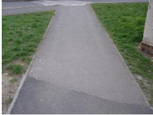
Obrázek 35 - Příklad povrchu bez poruch [6]
