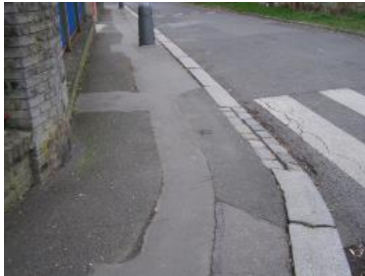
Obrázek 36 - Příklad povrchu s menšími poruchami [6]
