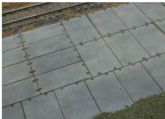
Obrázek 6 – Příklad povrchu z betonových panelů [zdroj http://modely.biz ]
