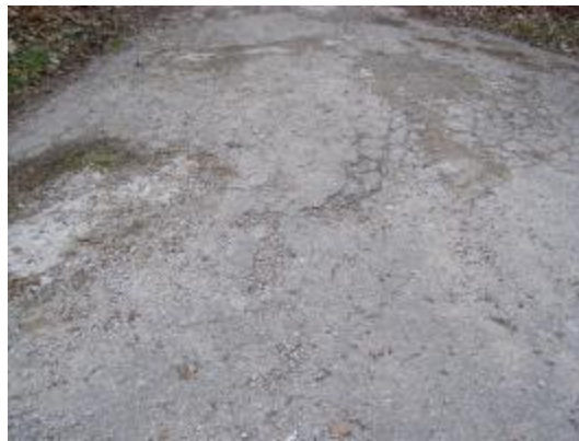
Obrázek 22 - Příklad povrchu s velkou četností poruch [3]
