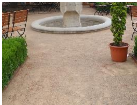
Obrázek 13 – Příklad povrchu z mlatu [foto POV]
