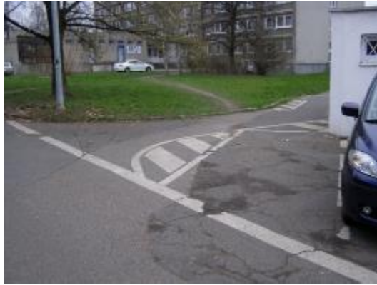
Obrázek 21 – Příklad povrchu s malou četností poruch [3]
