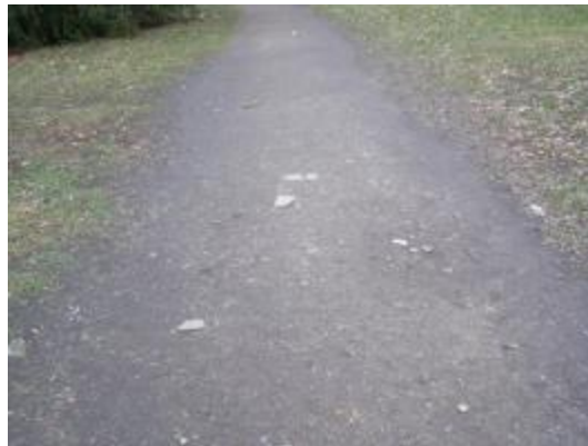
Obrázek 13 – Příklad nezpevněného povrchu [3]
