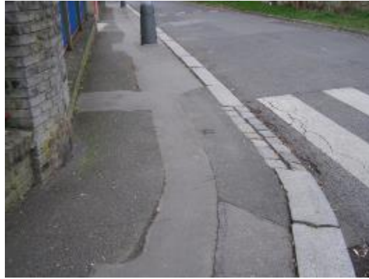
Obrázek 19 - Příklad povrchu s menšími poruchami [3]
